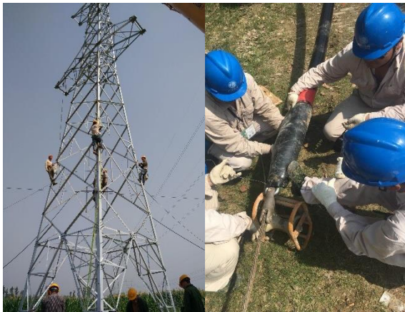
电力输、配电电缆线路工程
