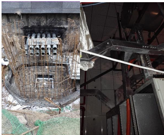
数据中心配电工程
